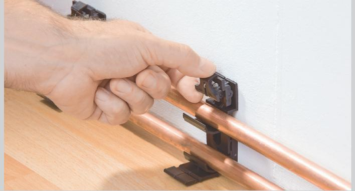
2. Federkralle an Befestigungsschelle spannen
